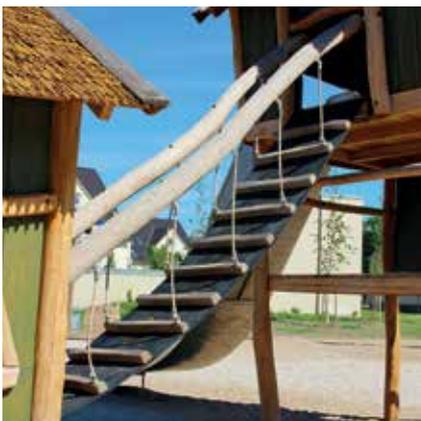
Gummibandbrücke mit Steighölzern
